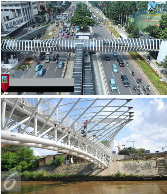
Gambar 1. Jembatan Penyeberangan orang
