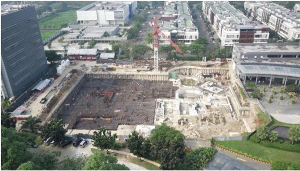
Gambar 1. Pelaksanaan Proyek Pembangunan Gedung Kampus XYZ
